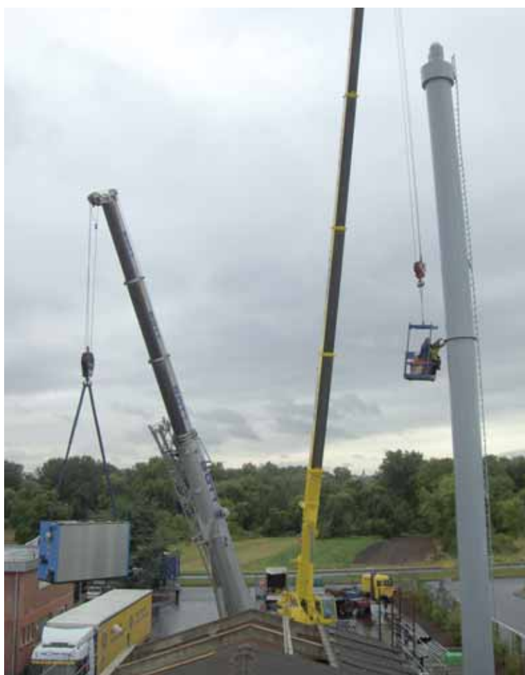
Kientzler investierte 750.000 Euro in eine neue Kohleheizung: Dazu gehören zwei Kessel (einer davon links am Haken) und ein 30 Meter hoher Schornstein (rechts)
