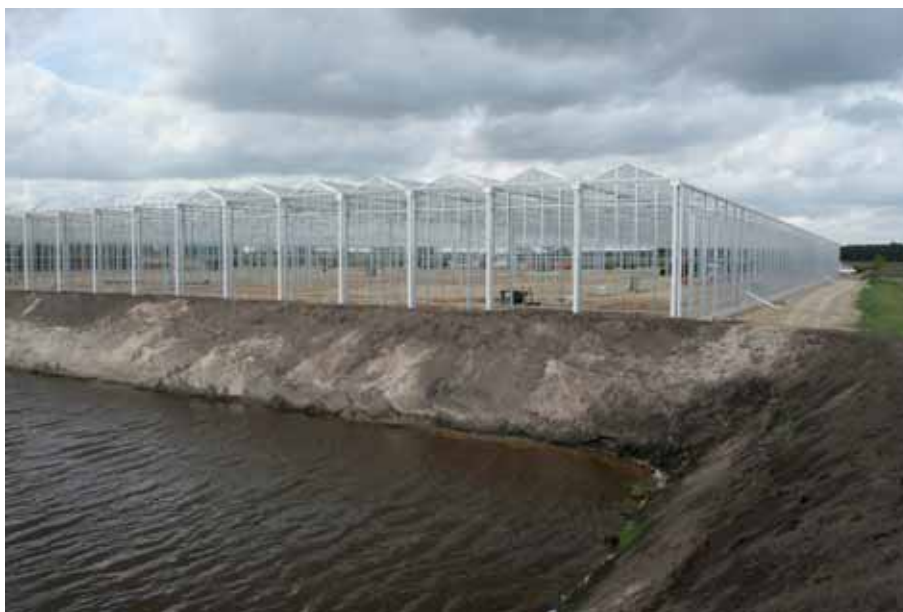
Stabile Konstruktion auf sandigem Unterboden: Wegen des windigen ostfriesischen Klimas waren größere Fundamente und zusätzliche Verstrebungen notwendig
