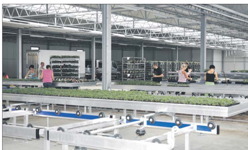
Die 6.000 Quadratmeter große Portalträgerhalle ist für die Verarbeitung großer Mengen in kurzer Zeit ausgelegt.
