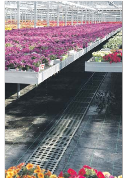
Überschusswasser tropft am Ende der Tische auf den Boden und wird gesammelt.
